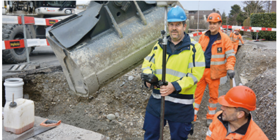
Früher von Hand, heute mit EDV-Unterstützung und GPS: Beat Lengweiler ist für die Vermessung und Dokumentation der Werkleitungen in und um Belp zuständig.
