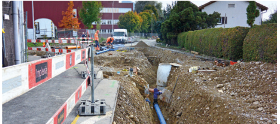
Ein modernes Versorgungsnetz für Elektrizität und Wasser bedarf laufender Sanierungsmassnahmen – hier am Beispiel der Aemmenmatt- und Muristrasse in Belp.
