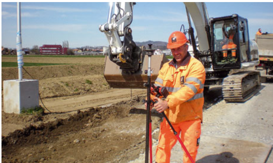
Letzte Etappe: Heinz Trachsel und sein Team auf der Baustelle Kumenstrasse.
