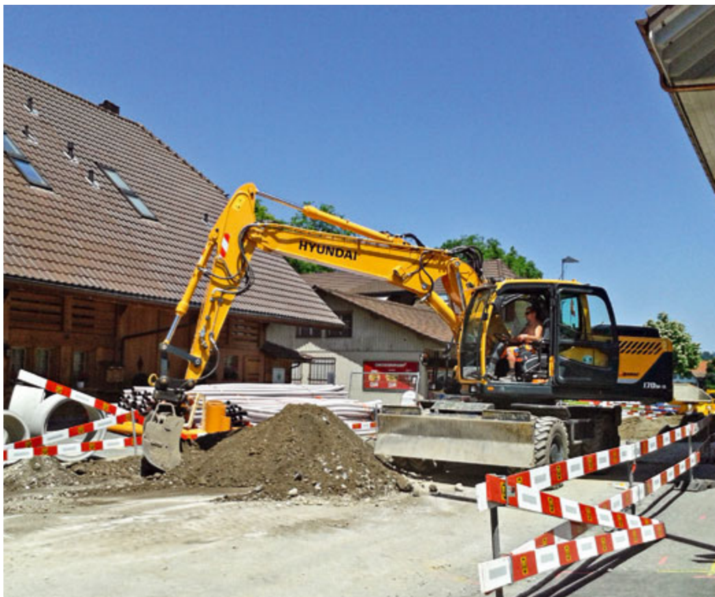
Die Käsereistrasse gehört ganz den Baumaschinen.
