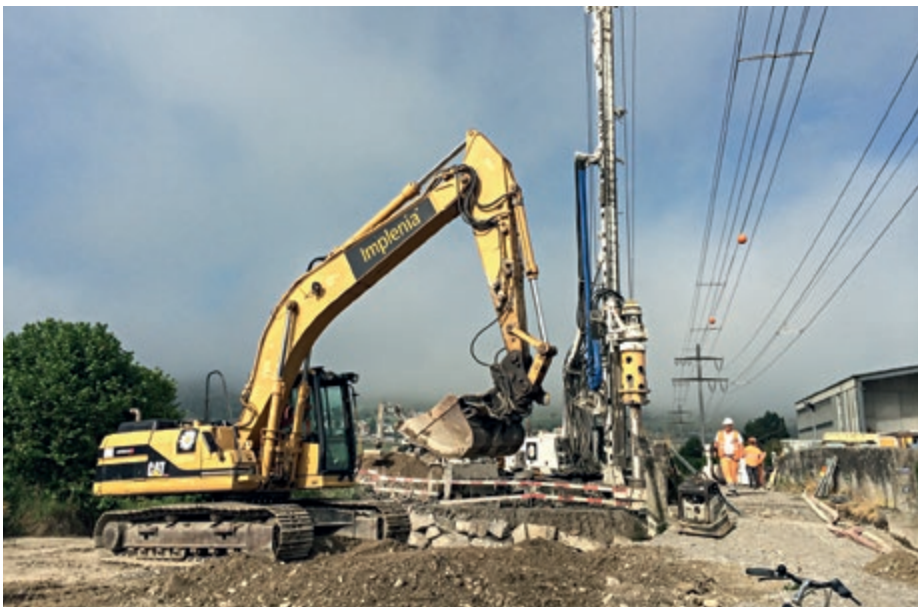
Der Bau der Stockmattbrücke erfordert schweres Gerät und einen niederen Gürbepegel.
