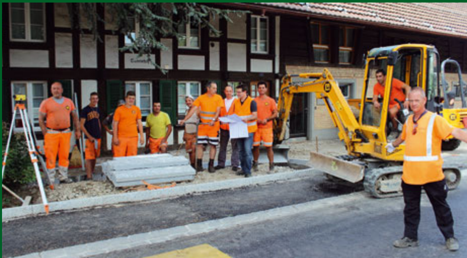
Sanierung Dorfstrasse – Käsereistrasse
