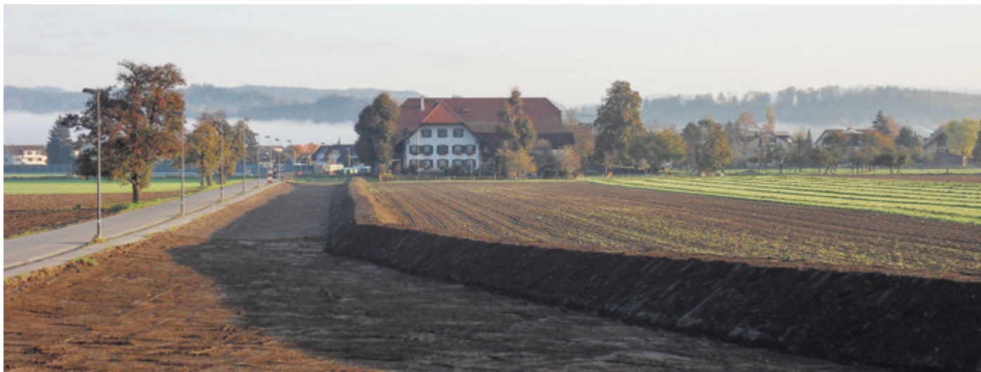
Das Terrain für den Ausbau der Kummenstrasse ab Lindenkreisel ist vorbereitet.
