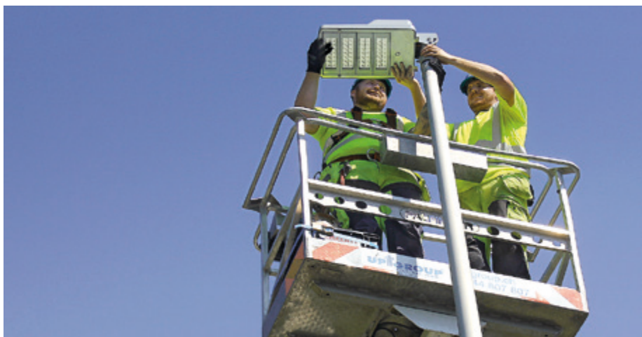
Mitarbeiter der Energie Belp AG montieren eine moderne, energieeffiziente LED-Leuchte an einem der insgesamt 1'275 Strassenkandelaber entlang der Gemeinde- und Kantonsstrassen.
